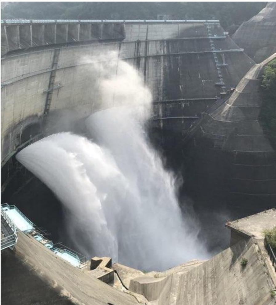
黒部川に建設された 水力発電専用ダムで 黒部川第四発電所（黒四）に送られている。 この発電所の名称から 黒四ダムとよばれている。
